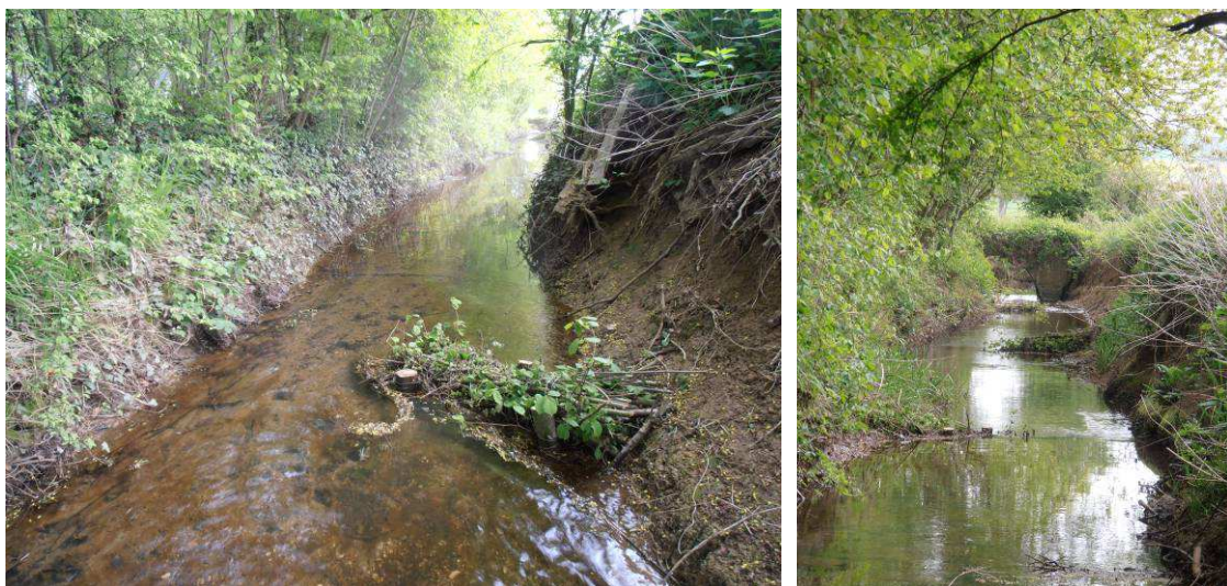
Réalisation d'aménagements rustiques afin de diversifier les secteurs homogènes et permettre de décolmater le fond du lit
