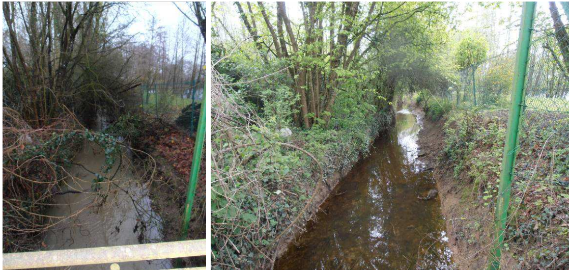
Coupe et désencombrement du lit du ruisseau sur zones difficiles d'accès (clôtures...).
