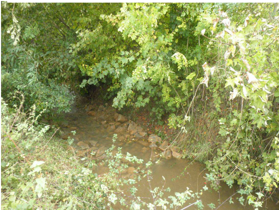
Intervention 2011 : Réalisation d'un seuil de fond avec dépôt de graviers en amont permettant de stopper le creusement du chenal et favorisant le dépôt de sédiments en amont.
