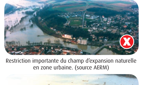
Restriction importante du champ d'expansion naturelle en zone urbaine. (source AERM)
