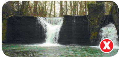
LA VAUX : barrage abandonné. (source ONEMA)
