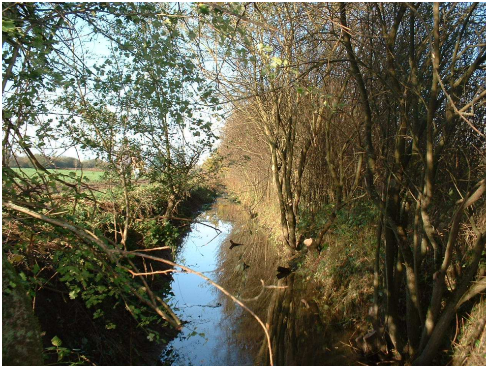
Après travaux de coupe sélectives
