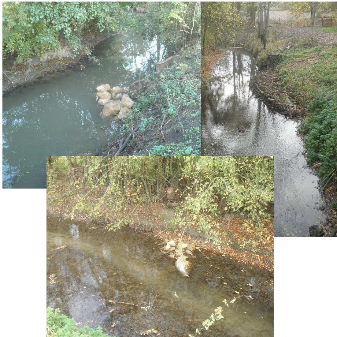
Mise en place d'aménagements (déflecteurs en pierre, peignes) afin de diminuer la largeur du lit et diversifier les écoulements.
