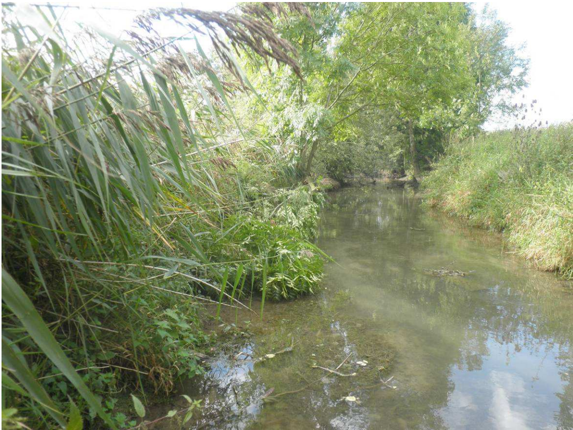
Réouverture du milieu (coupe de la végétation buissonnante et retrait des branchages du lit).
