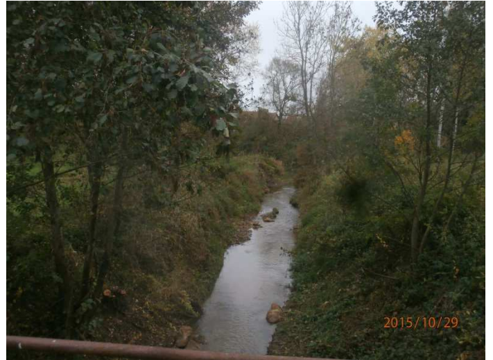
Apport de blocs et substrat pour diversifier le lit mineur
