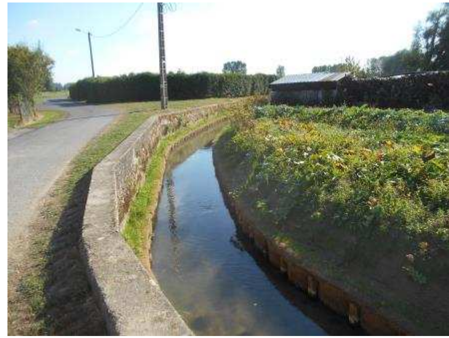
Amont de la STEP
