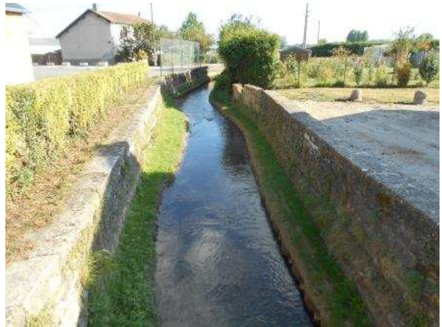
Aval du Pont de la Mairie
