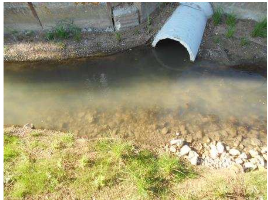
Sortie de buse le long de l'Eglise : allongement de la sortie et rétrécissement pour accentuer l'effet « chasse »
