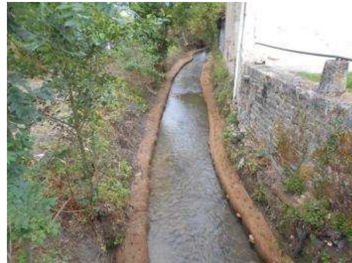
Aval du Pont de la rue du Villers
