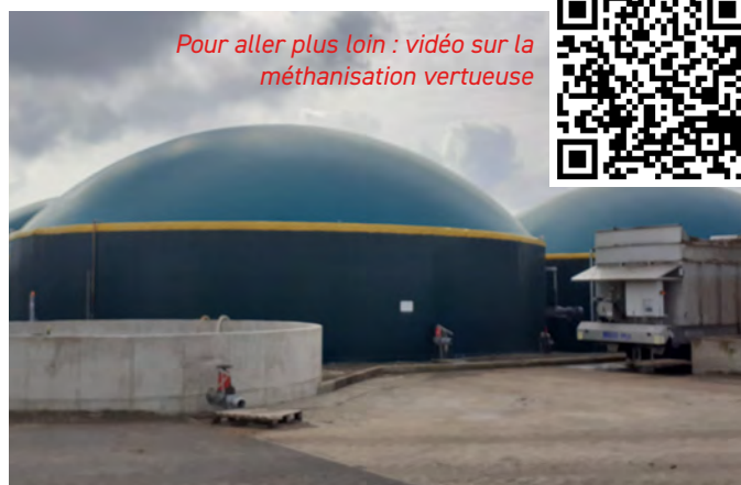
Unité de méthanisation Val BIOENERGIE
